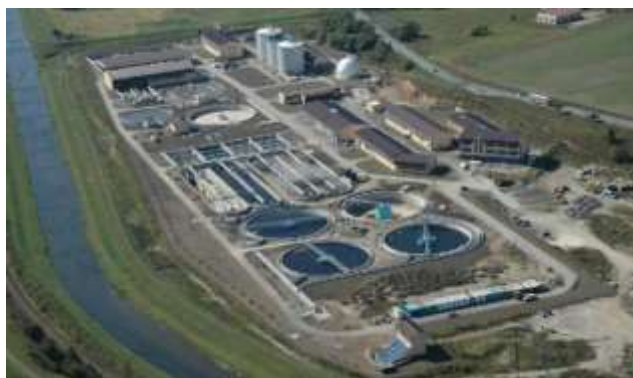
Obrázok 3. Čistiareň odpadových vôd (Poprad – Matejovce)
